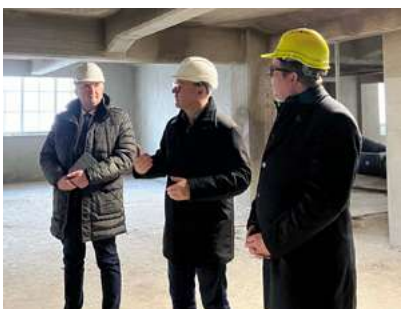
Gemeinsame Baubesichtigung des Zwönitzer Speichers mit STM Thomas Schmidt und BM Wolfgang Triebert Foto: Büro Tom Unger MdL
